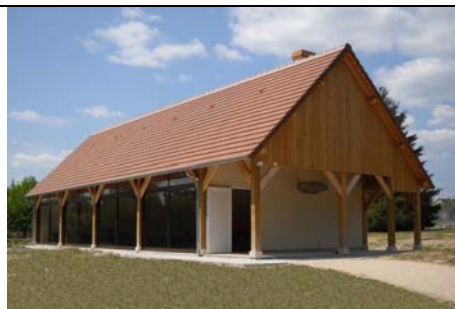
Valorisation du bois construction pour cette salle commune de Neung-sur-Beuvron (camping).
